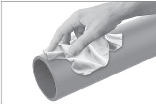
**Passo 3:** Com uma estopa ou pano limpo e seco, limpe as superfícies das extremidades dos tubos e das bolsas das conexões;
