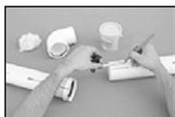
**Passo 2:** Marcar a profundidade da bolsa na ponta do tubo;
