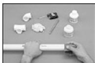
**Passo 1:** Verificar se a bolsa da conexão e a ponta dos tubos a ligar estão perfeitamente limpas. Por meio de uma lixa d'água, tirar o brilho das superfícies a serem soldadas, objetivando aumentar a área do ataque do adesivo;
