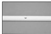
**Passo 1:** Para resolver os problemas que ocorrem em pontos localizados nos tubos em instalações já concluídas, em consequência de pequenos acidentes (furos por pregos ou furadeiras), ou vazamentos em juntas mal executadas, a TIGRE oferece aos seus consumidores a Luva de Correr TIGRE;
