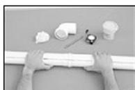
**Passo 4:** Encaixar a ponta chanfrada do tubo no fundo da bolsa, recuar 5mm no caso de canalizações expostas e 2mm para canalizações embutidas, tendo como referência a marca previamente feita na ponta do tubo. Esta folga se faz necessária para a dilatação da junta.
