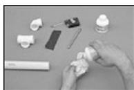
**Passo 2:** Limpar as superfícies lixadas com Solução Limpadora TIGRE, eliminando impurezas e gorduras. Observar que o encaixe deve ser bastante justo, quase impraticável em o adesivo, pois sem pressão não se estabelece a soldagem;
