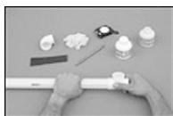
**Passo 4:** Encaixar as partes e remover qualquer excesso de adesivo.
