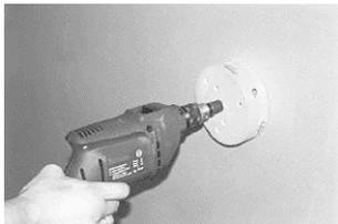
**1) Furar a placa:** Com a serra copo apropriada (vide tabela no final deste item), proceda ao furo da placa de gesso acartonado, conforme figura ao lado;
