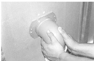
**2) Parafusar o joelho:** Com o parafuso adequado (TTPC de 25mm) deve-se proceder à fixação da conexão à placa. Para facilitar a operação deve uma pessoa segurar a conexão e a outra parafusá-la (vide figuras ao lado);
